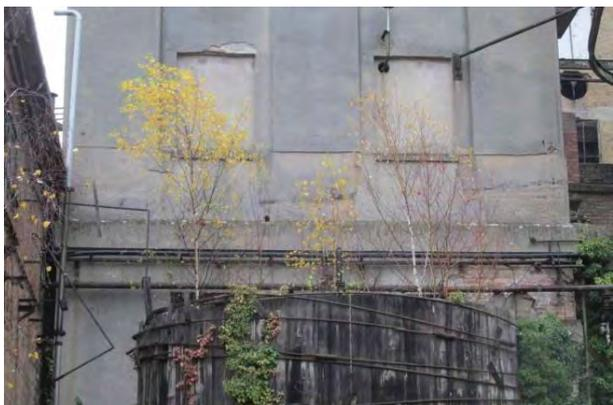
**Abb. 32:** Gehölze auf einem Bauwerk / einer Dachfläche
