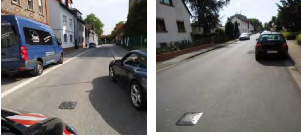
Abbildung 6: Erfassungsgerät mit Magnetfeldtechnologie am Querschnitt 1 und 2
