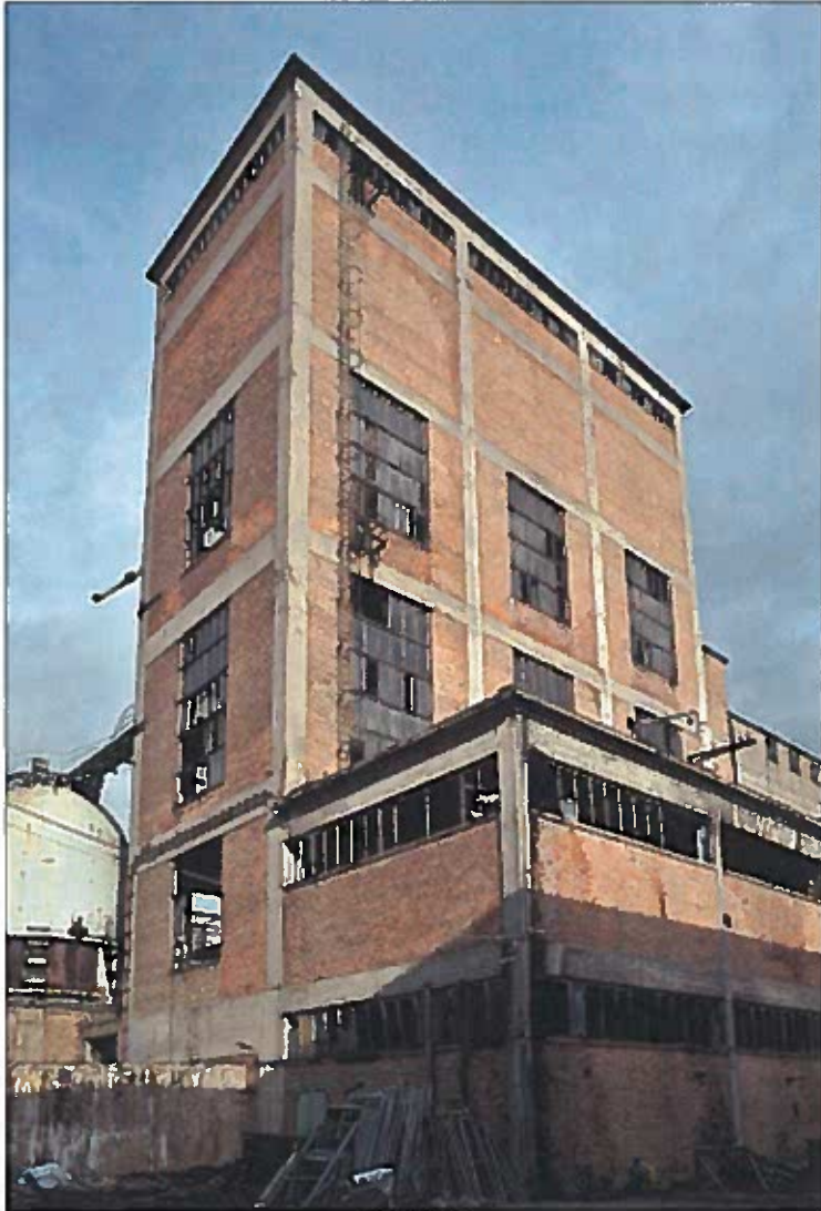
Bild 60 Ansicht von Südwesten
