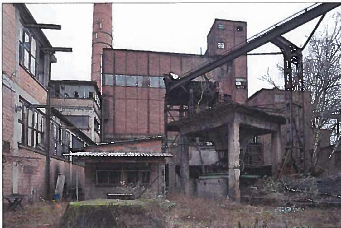
Bild 43 Ansicht von Südwesten
