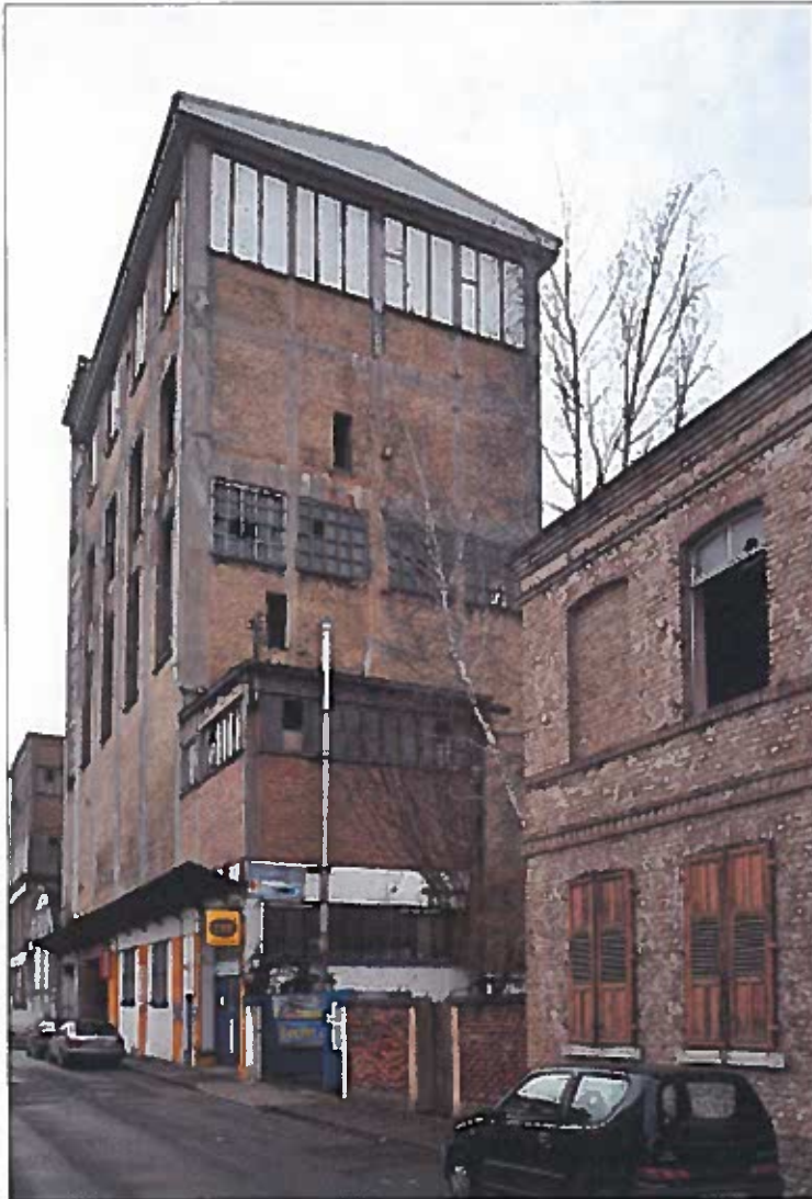
Bild 47 Ansicht von Nordosten
