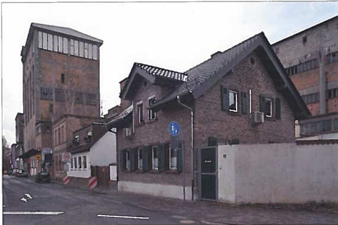
Bild 48 Ansicht von Norden
