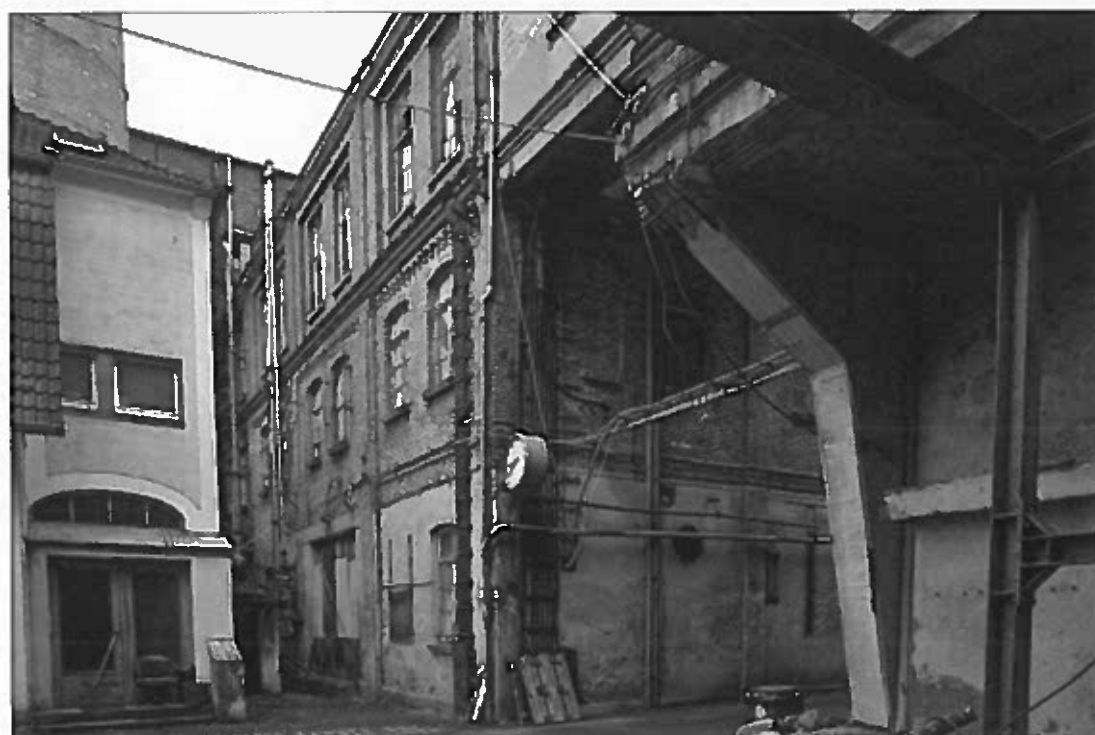
Bild 21 Ansicht von Norden
