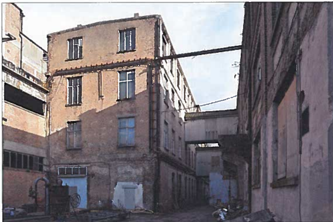
Bild 12 Ansicht von Südwesten
