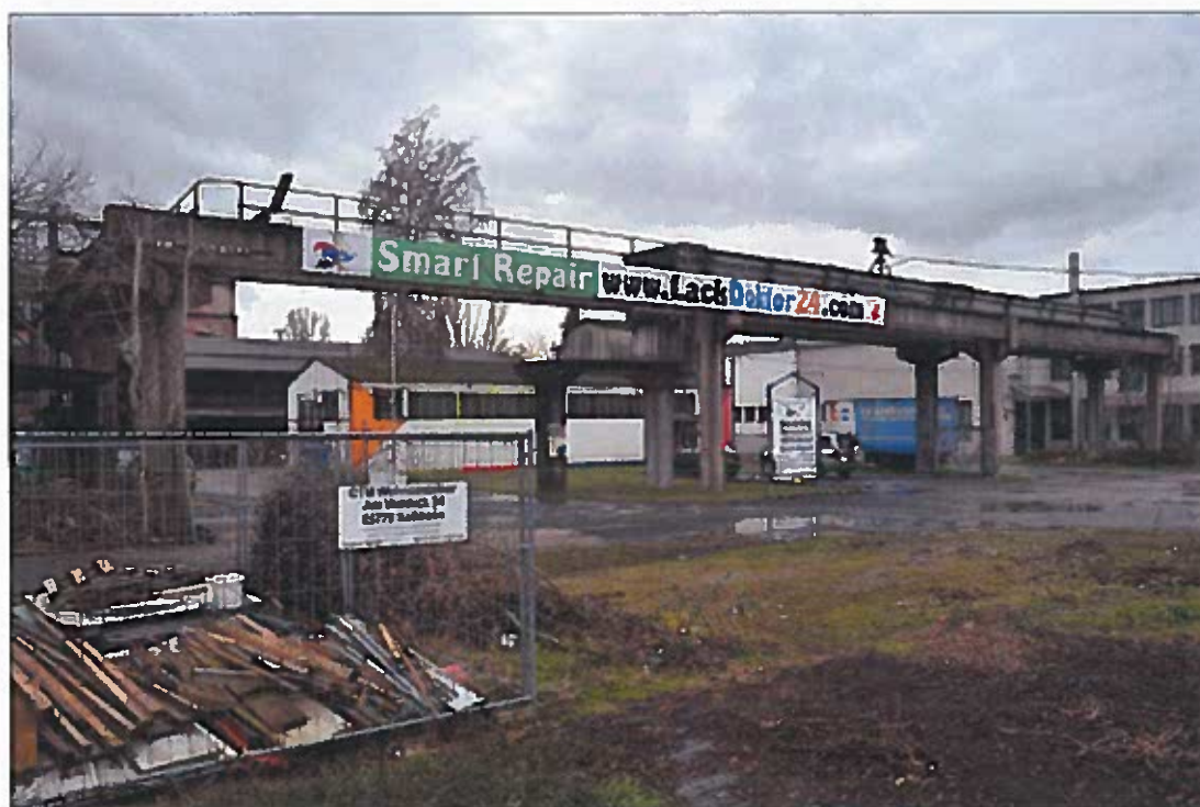
Bild 77 Ansicht von Norden
