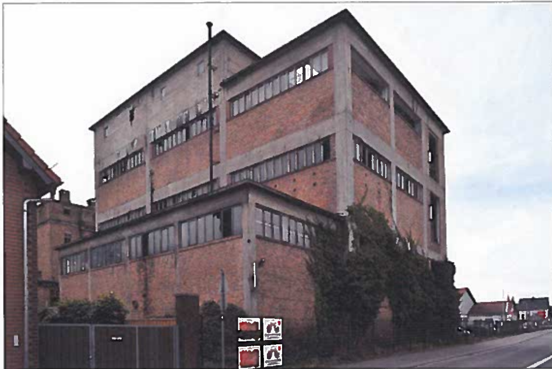
Bild 64 Ansicht von Norden
