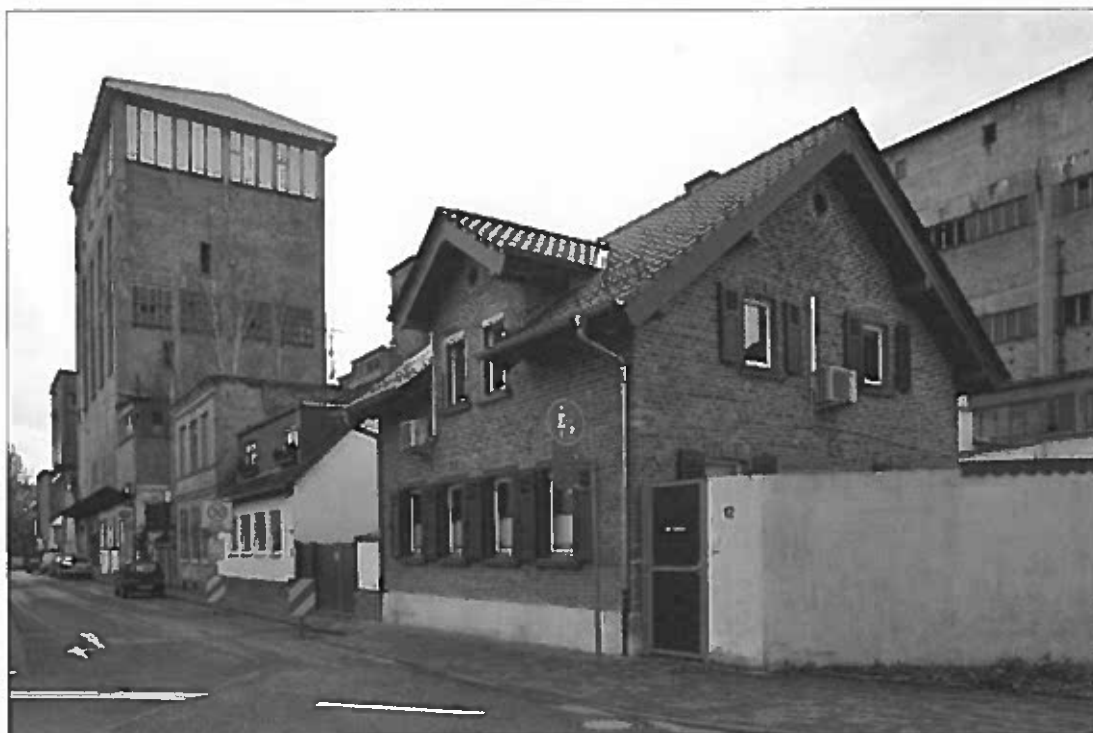
Bild 18 Ansicht von Norden
