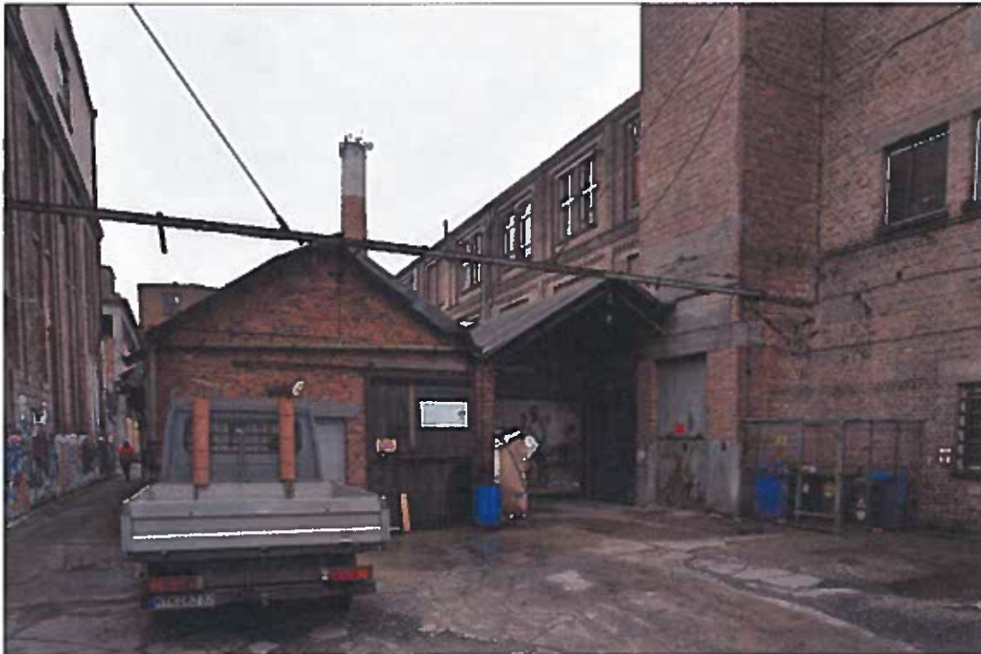
Bild 11 Ansicht von Südwesten
