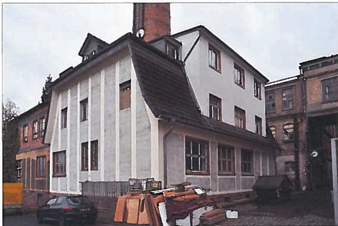
Bild 13 Ansicht von Nordosten
