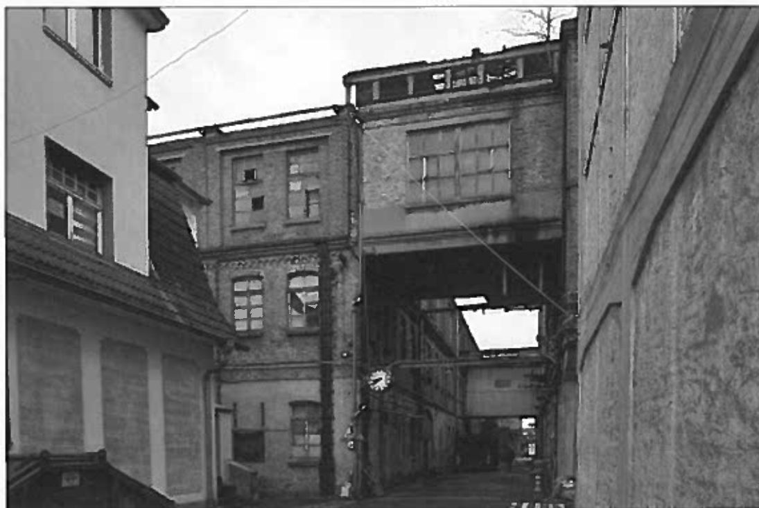
Bild 20 Ansicht von Nordosten
