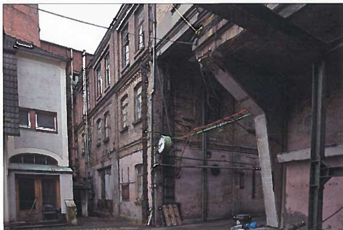
Bild 14 Ansicht von Norden. Eingang
