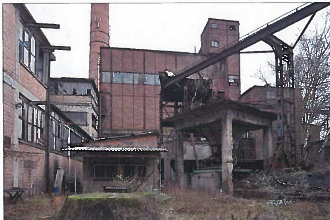
Bild 27 Ansicht von Südwesten
