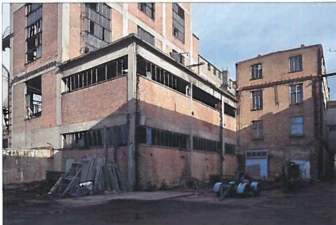
Bild 59 Ansicht von Südwesten
