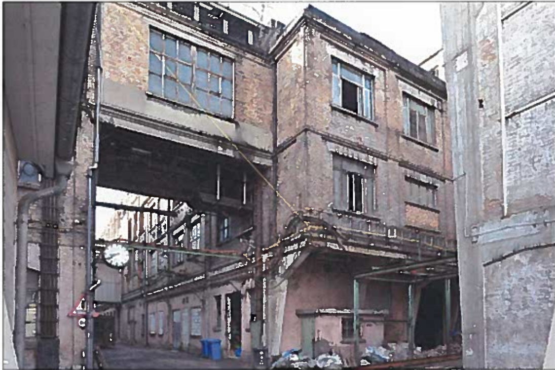
Bild 07 Ansicht von Osten
