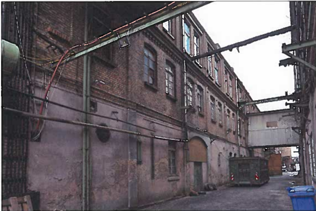
Bild 01 Ansicht von Nordosten
