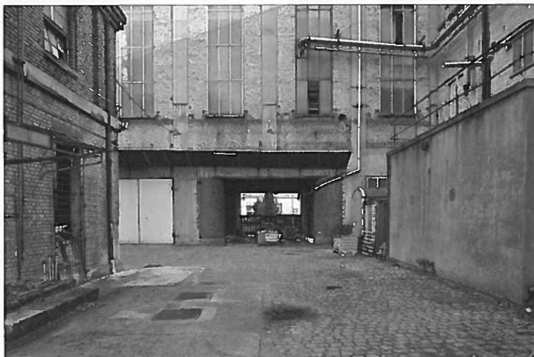
Bild 50 Ansicht von Südwesten. Durchfahrt
