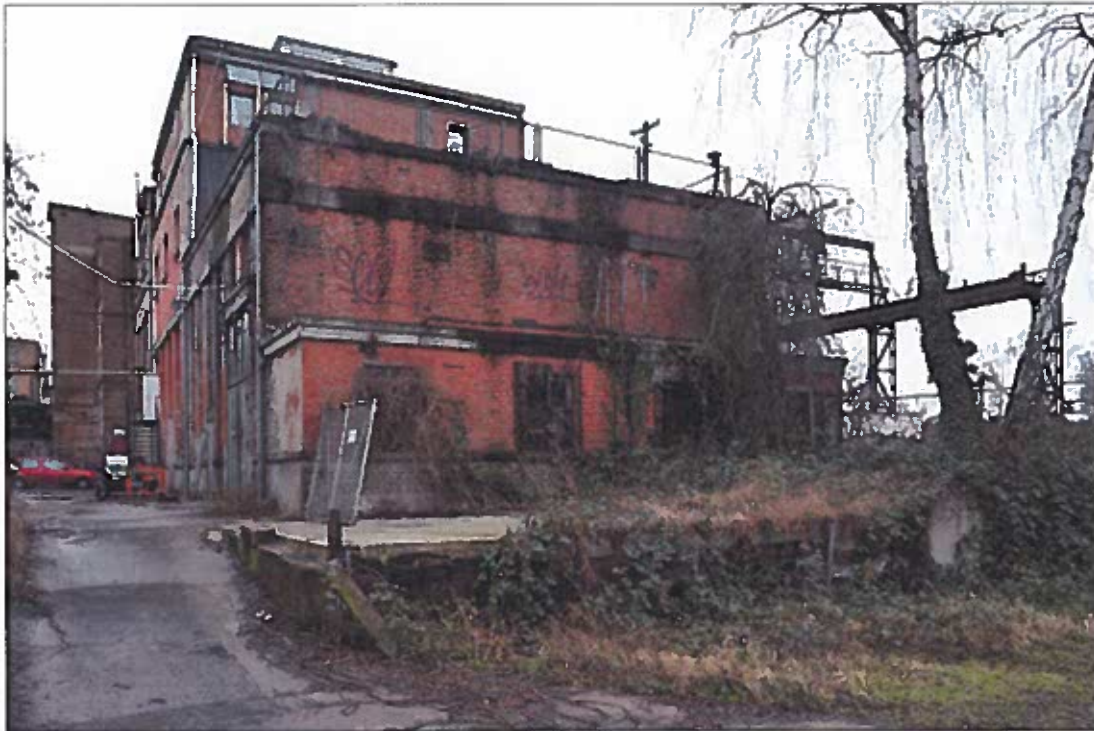
Bild 37 Ansicht von Osten
