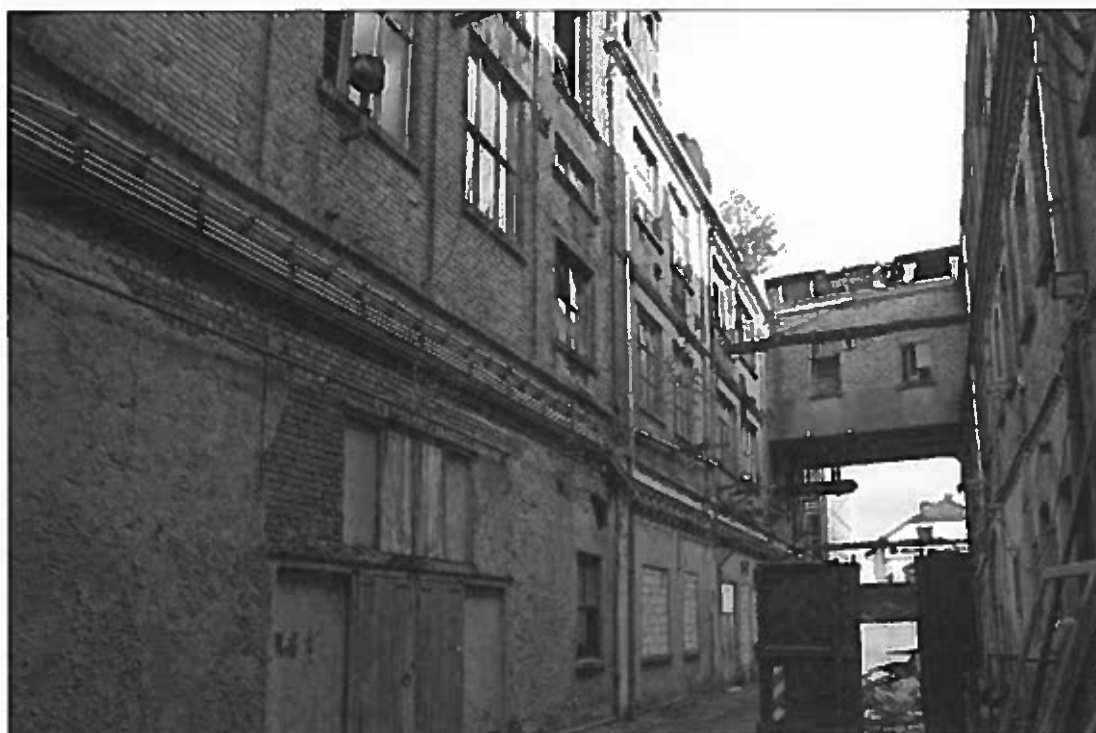
Bild 10 Ansicht von Südwesten
