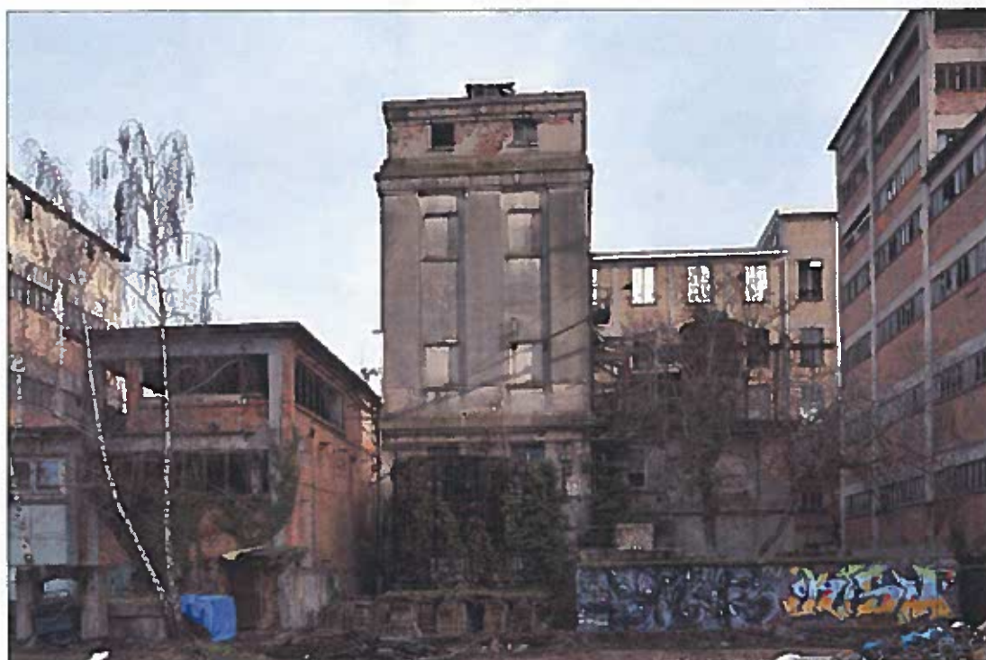
Bild 63 Ansicht von Südwesten
