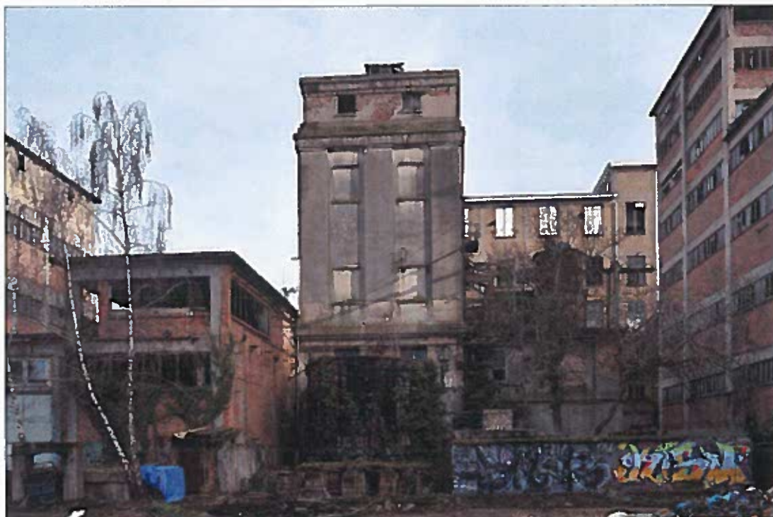
Bild 40 Ansicht von Südwesten
