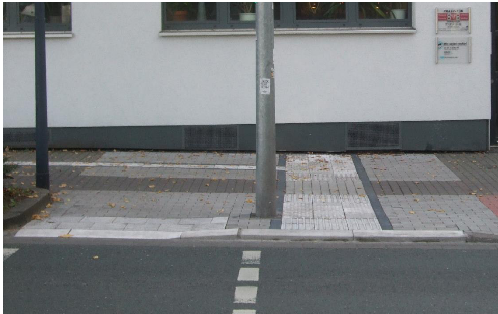
Abbildung 12: Prinzip der Doppelquerung (Nullabsenkung zzgl. Kante)
