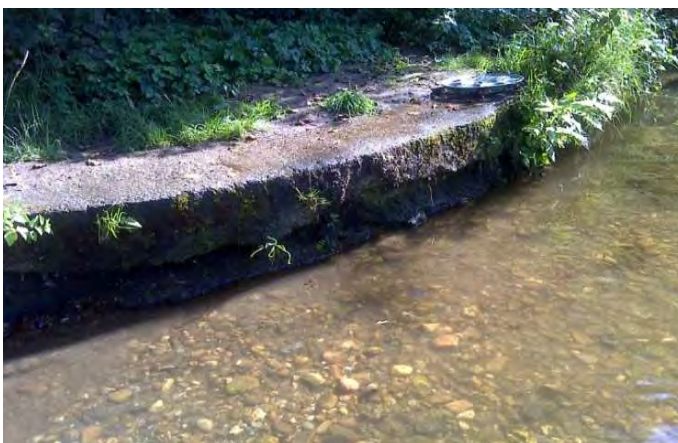
Betonmauer, linkes Ufer
