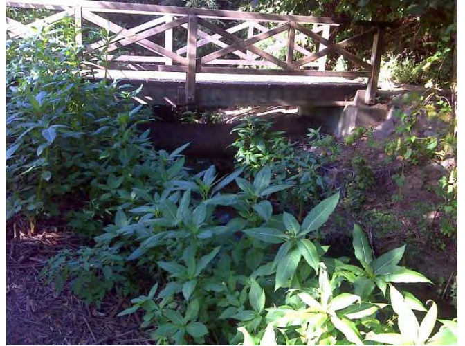
Umgehungsgerinne mit Holzbrücke
