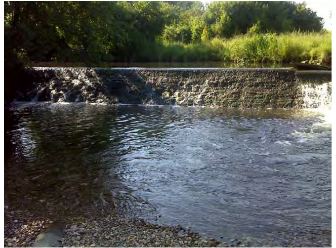
Blick von Unterwasser
