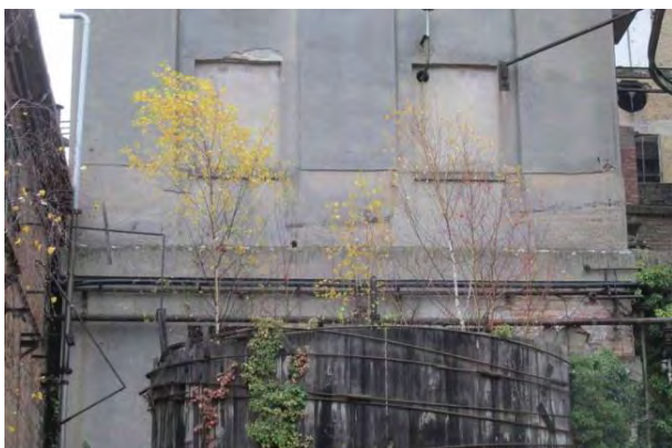
Abb. 33: Gehölze auf einem Bauwerk / einer Dachfläche
