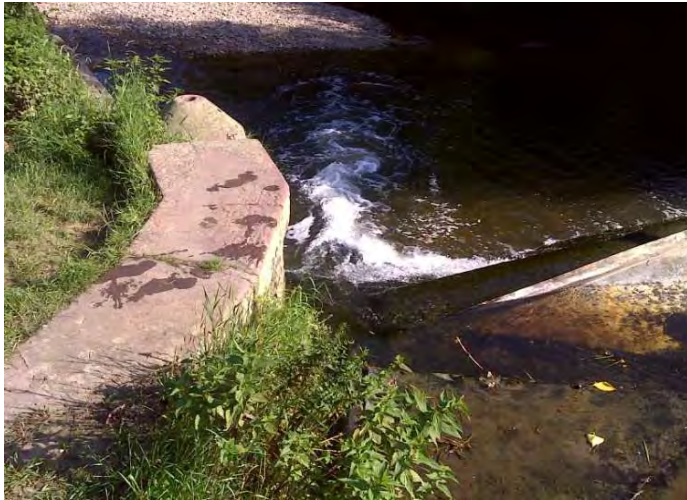
Betonmauer, linkes Ufer
