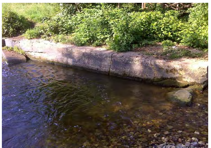
Betonmauer, rechtes Ufer
