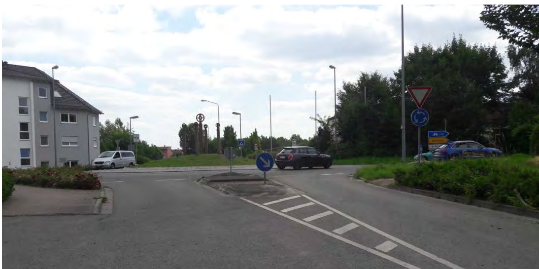
Abbildung 2.4: Fotodokumentation – Kreisel, Blick nach Süden
