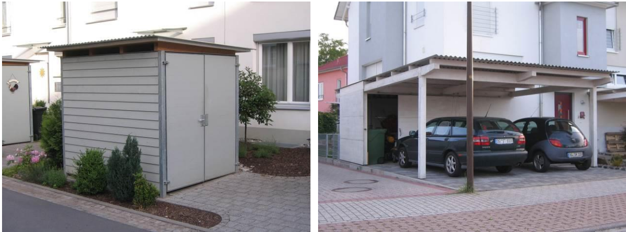
Abbildung: Abstellanlage als separate Anlage oder im Zusammenhang mit einem Carport
