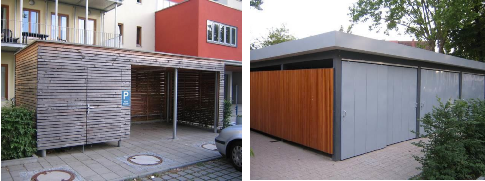
Abbildung: Abstellanlage als separate Anlage oder im Zusammenhang mit einer Garagenanlage (hier längere Garage mit separatem rückwärtigem Zugang)
